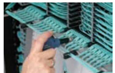
写真 21.3 使用例：パッチパネル側の端面検査
